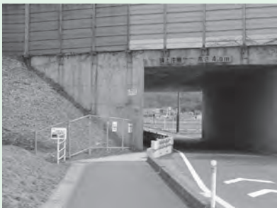
ガードレールが設置された通学路
