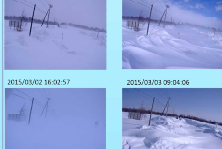
定点カメラによる吹き溜まり監視
