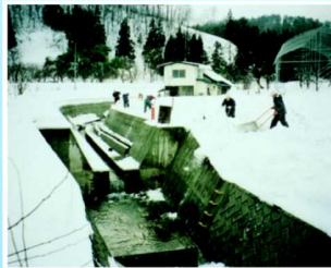
除排雪低水路(山形県村山市)
