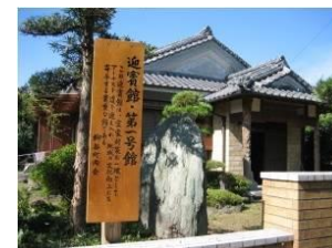
改修した古民家 (出典) やねだんwebサイト
