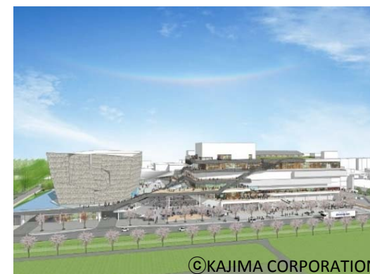
（仮称）ところざわサクラタウン
