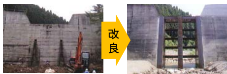
透過型砂防堰堤への改良
