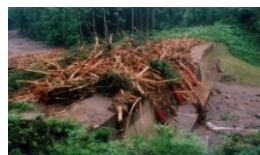
流木捕捉式治山ダムの設置
