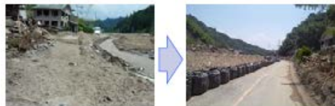
道路啓開の実施
