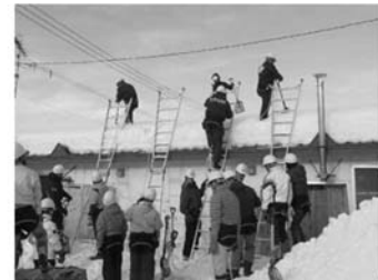
雪下ろし実技講習
