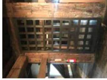
「天守閣の木製格子壁による補強」
