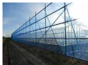
防風ネットの設置
