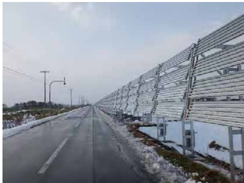
防雪柵の整備
