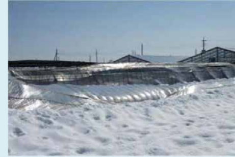
・積雪によるハウスの倒壊
