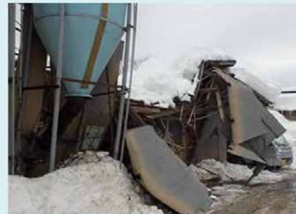
・積雪による牛舎の倒壊
