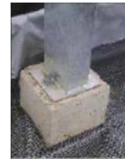
ソイルセメントを用いた基礎部の補強
