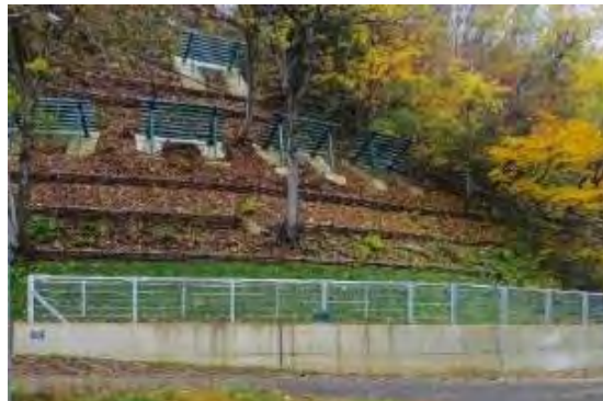
雪崩防止柵の整備
