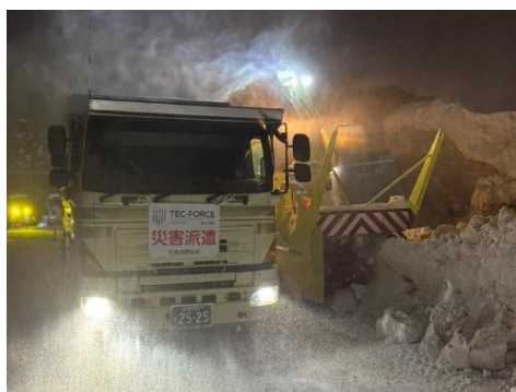
支援機械による排雪作業(札幌市)
