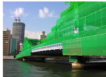
橋りょうの補修
