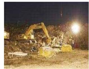
2011.12 夜間作業の様子 (宮城県石巻市)
