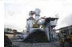
仮設焼却炉(仙台市)→
